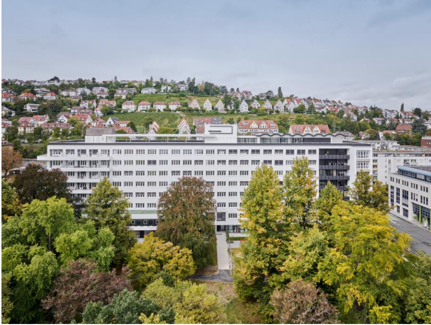
136 Wohnungen sind in dem ehemaligen Bettenhaus entstanden. Foto: Jürgen Pollak.
