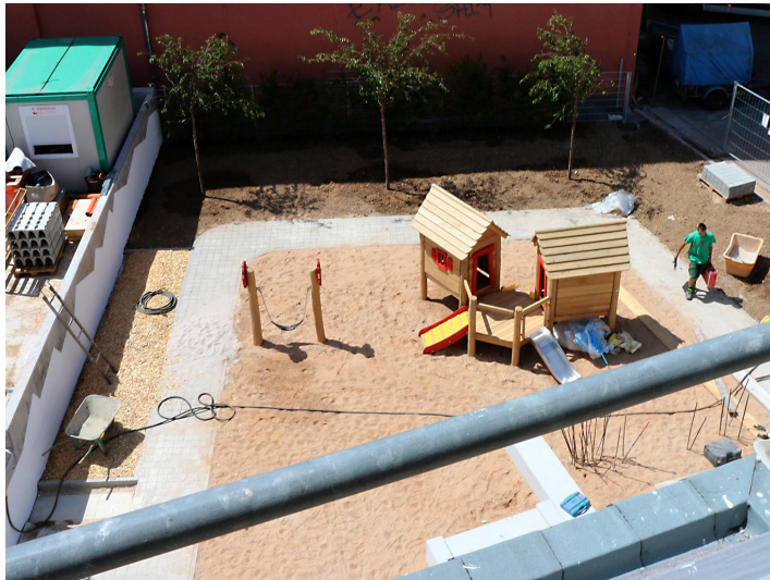
Zum Teil stehen schon die Spielgeräte für die Kita.
