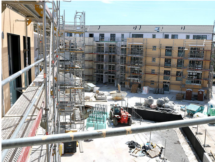
Gerüste und verputzte Fassaden im Innenhof.
