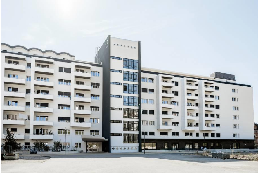
Das ehemalige Bettenhaus des Bürgerhospitals beherbergt heute 136 Wohnungen. Foto: Tamara Tabery.
