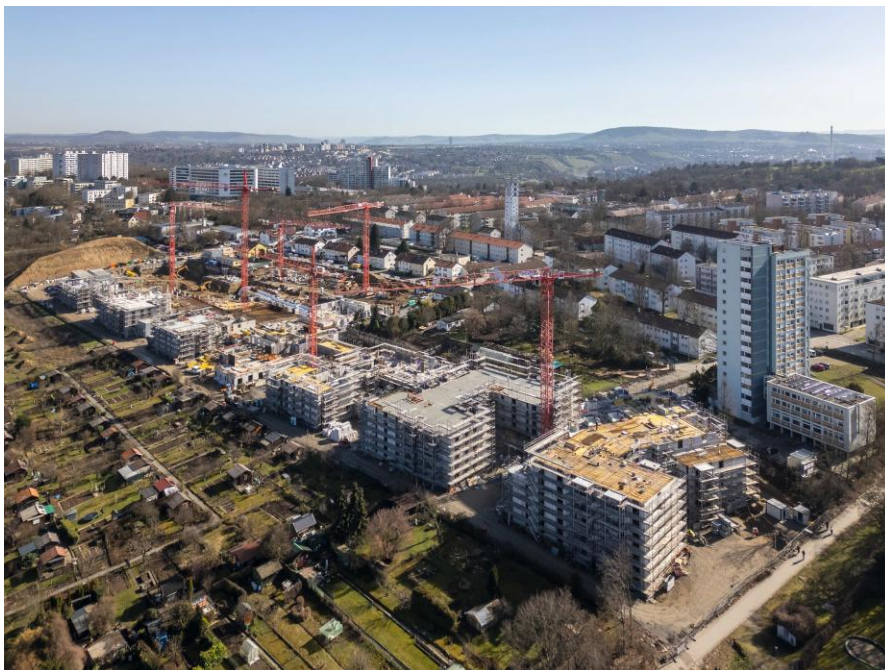
Im Großprojekt an der Böckinger Straße entstehen u. a. 400 neue Wohnungen. Foto: Sebastian Bullinger.
