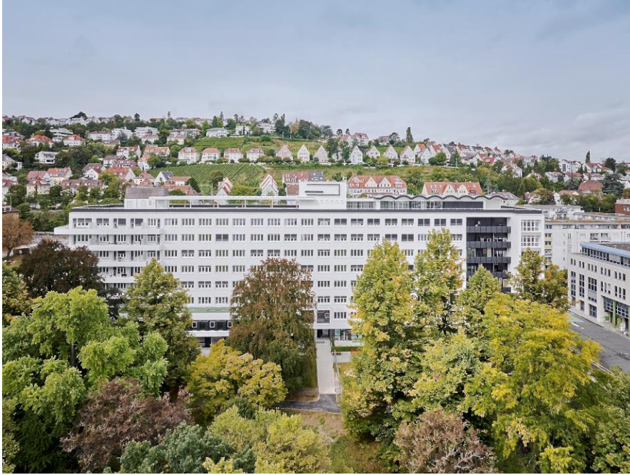
136 neue Wohnungen hat die SWSG im ehemaligen Bettenhaus geschaffen. Foto: Jürgen Pollak.
