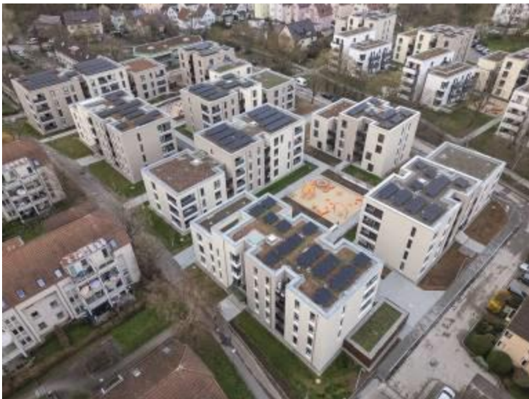
Mehr bezahlbarer Wohnraum: In der Keltersiedlung in Stuttgart-Zuffenhausen hat die SWSG 180 Wohnungen gebaut. Foto: Sebastian Bullinger.
