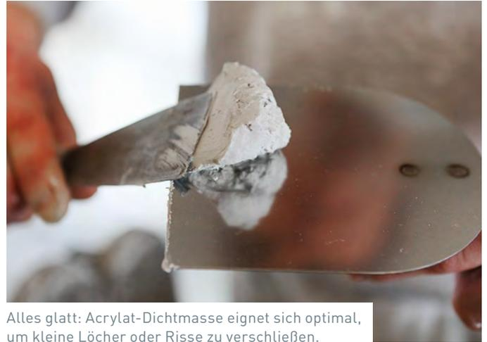
Alles glatt: Acrylat-Dichtmasse eignet sich optimal, um kleine Löcher oder Risse zu verschließen.
