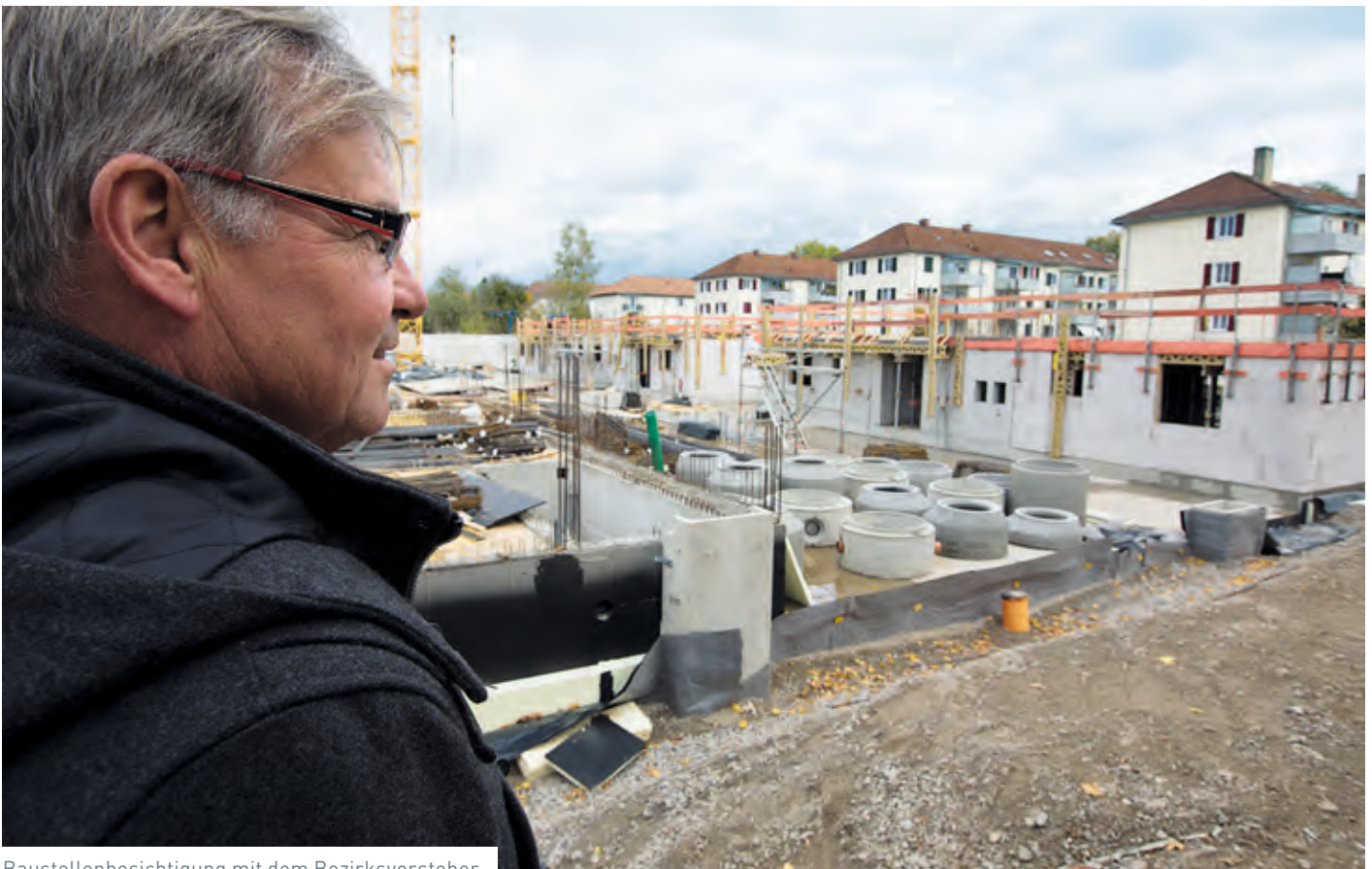
Baustellenbesichtigung mit dem Bezirksvorsteher.
