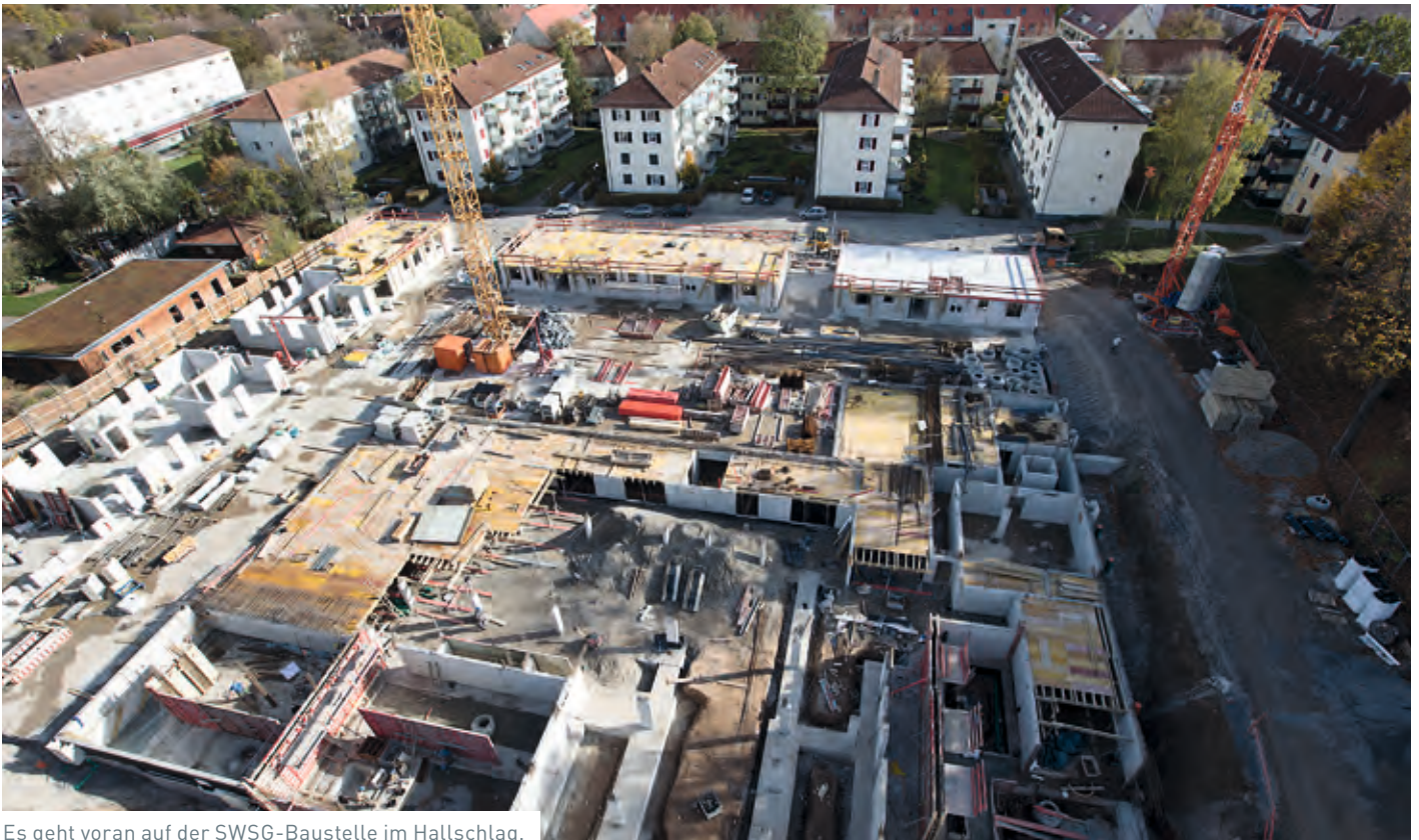
Es geht voran auf der SWSG-Baustelle im Hallschlag.
