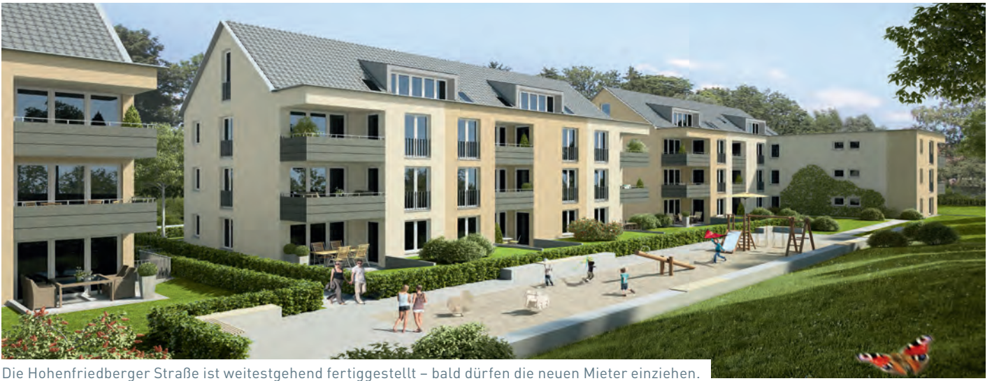
Die Hohenfriedberger Straße ist weitestgehend fertiggestellt – bald dürfen die neuen Mieter einziehen.
