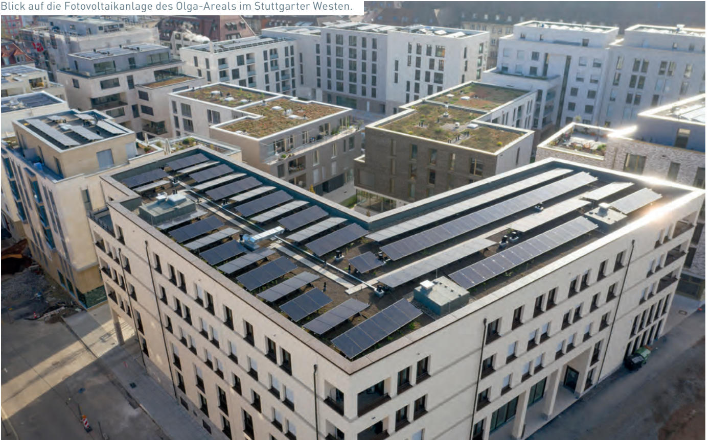
Blick auf die Fotovoltaikanlage des Olga-Areals im Stuttgarter Westen.
