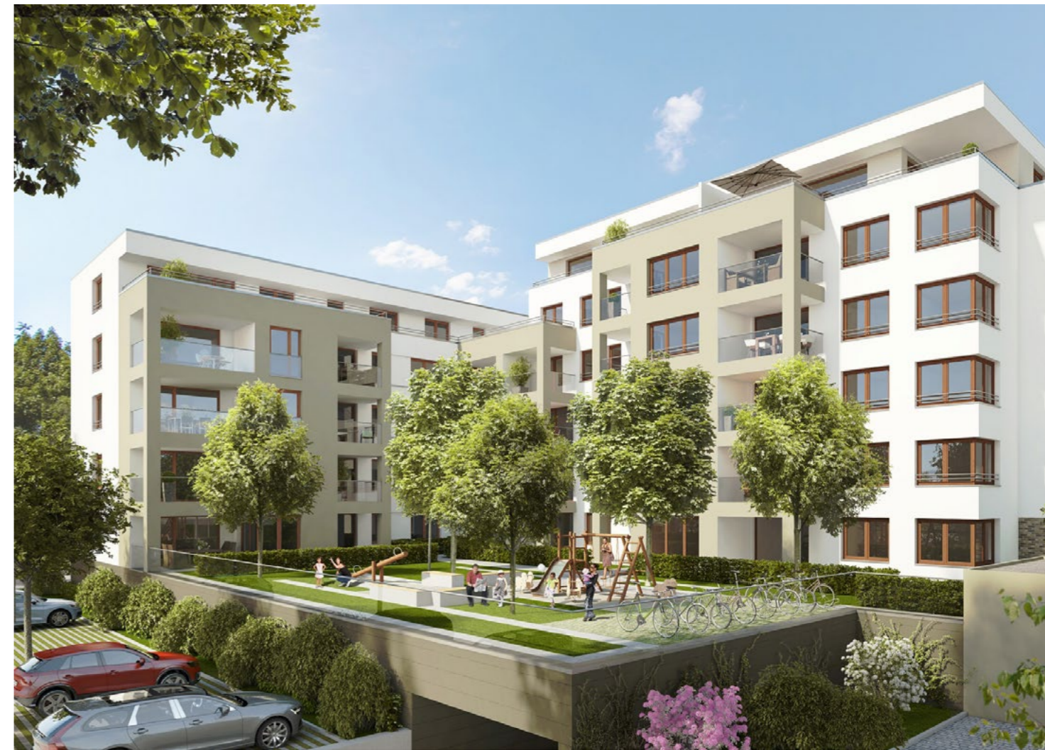
Neuer Wohnraum entsteht an der Balthasar-Neumann-Straße.
