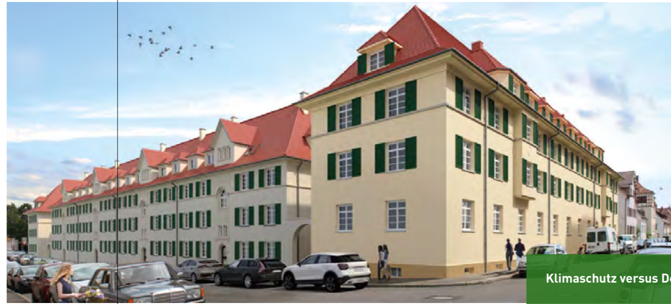
Eine echte Herausforderung: die klimagerechte Modernisierung denkmalgeschützter Gebäude, wie hier die Vatikan-Siedlung.
