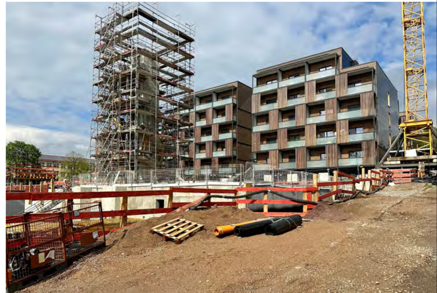
Im zweiten Bauabschnitt am Priessnitzweg geht es voran.
