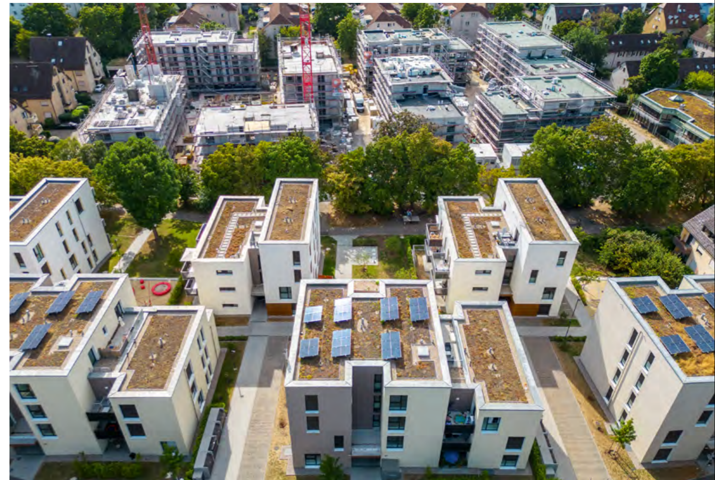
Der erste Bauabschnitt der Keltersiedlung ist bereits bezogen – im zweiten Bauabschnitt entstehen weitere 116 Wohnungen.
