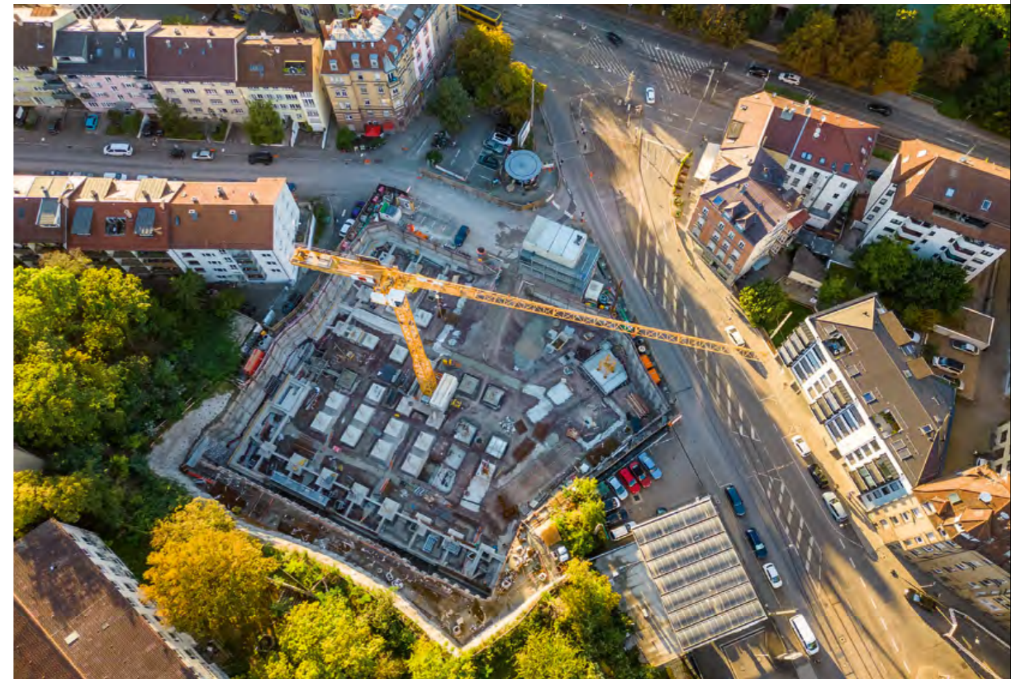
Die Rohbauarbeiten an der Hackstraße haben begonnen.
