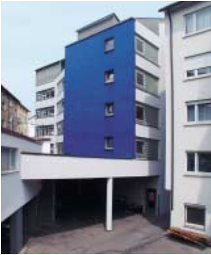
Stuttgart-West, Ausbau des Geschäftshauses Herzogstraße 15
