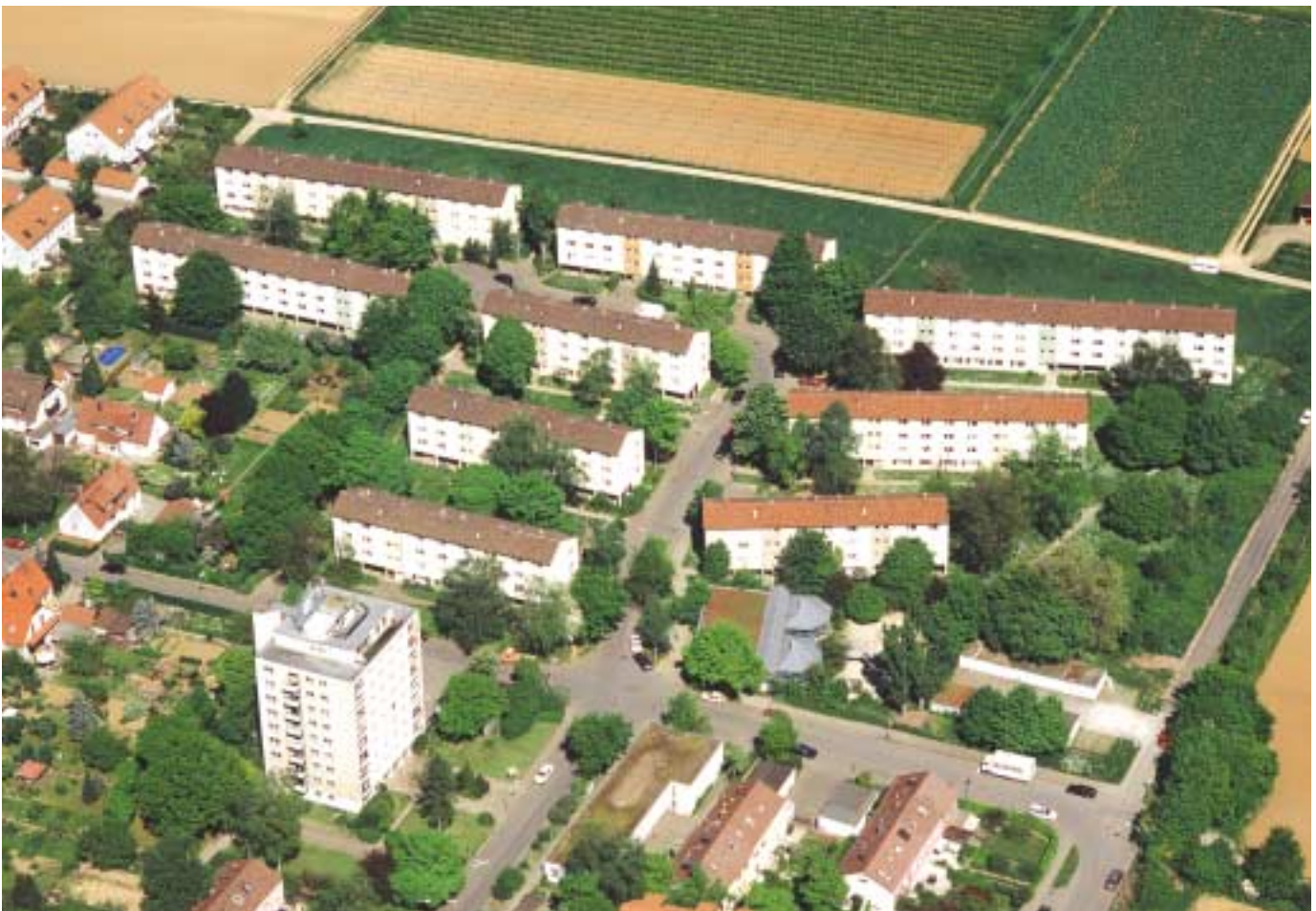
Stuttgart-Steinhaldenfeld, sanierungsbedürftige Wohnsiedlung „Falchstraße“
