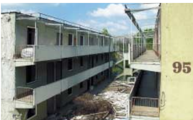
Stuttgart-Freiberg, Balthasar-Neumann-Straße, Abbruch der veralteten Fürsorgeunterkünfte
