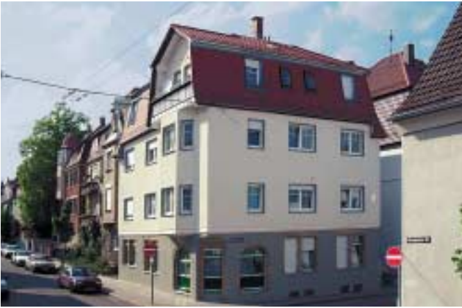
Stuttgart-Zuffenhausen, Besigheimer Straße 39, Bestandssanierung
