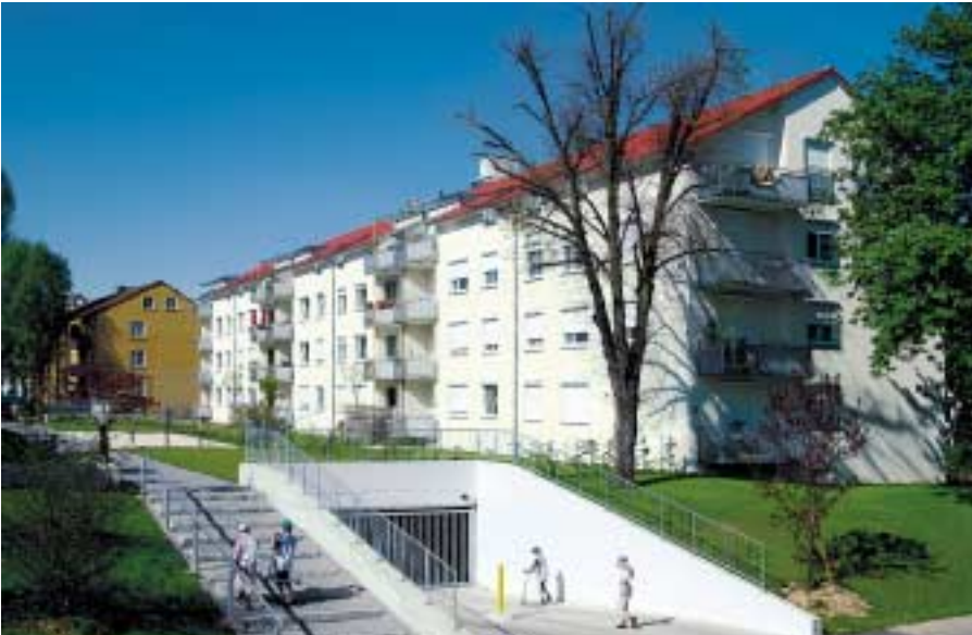
Stuttgart-Dürlewang, Galileistr. 62 - 66, Modernisierung mit Dachgeschossausbau, Neubau Tiefgarage und Neugestaltung der Aussenanlagen
