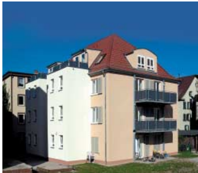
Stuttgart-Bad Cannstatt, Duisburger Straße 3/1, Altbaumodernisierung
