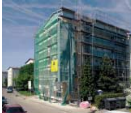
Stuttgart-Rot, Auricher Straße 57, Bestandssanierung
