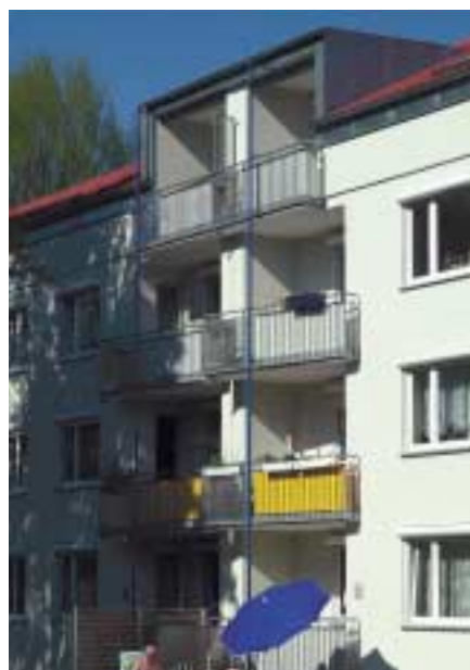
Stuttgart-Dürtlewang, Schopenhauerstr 43 A-C, Modernisierung mit Dachgeschossausbau
