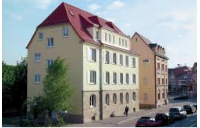
Stuttgart-Zuffenhausen, Marconistraße 19 -23, Bestandssanierung
