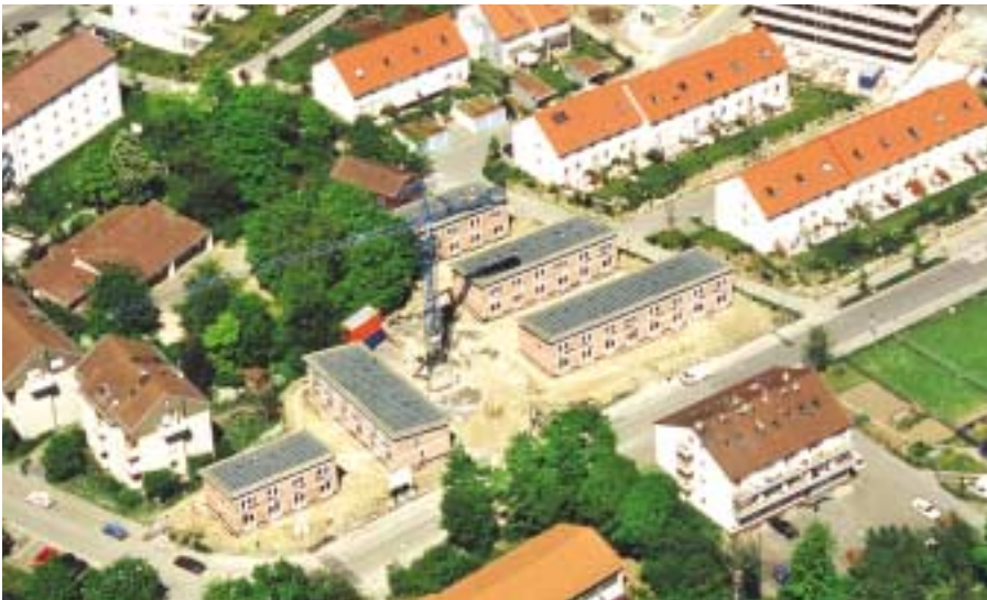
Stuttgart-Fasanengarten, Hausenring 18 -30 Reihenhausbau durch die SWSG
