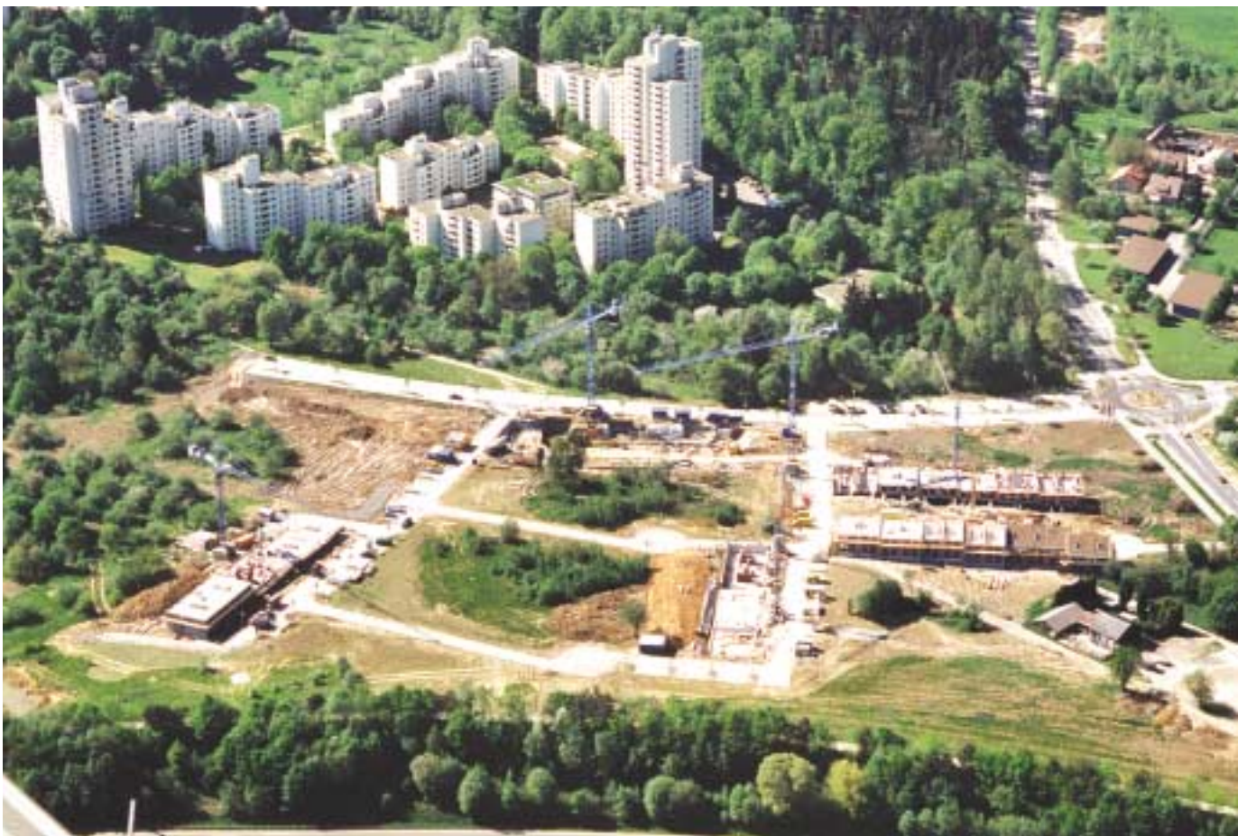
Stuttgart-Vaihingen, Neubaugebiet „Lauchäcker“
