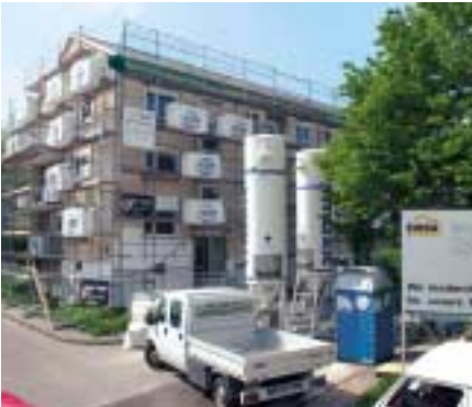
Stuttgart-Mönchfeld, Makrelenweg 10 - 16, Bestandssanierung
