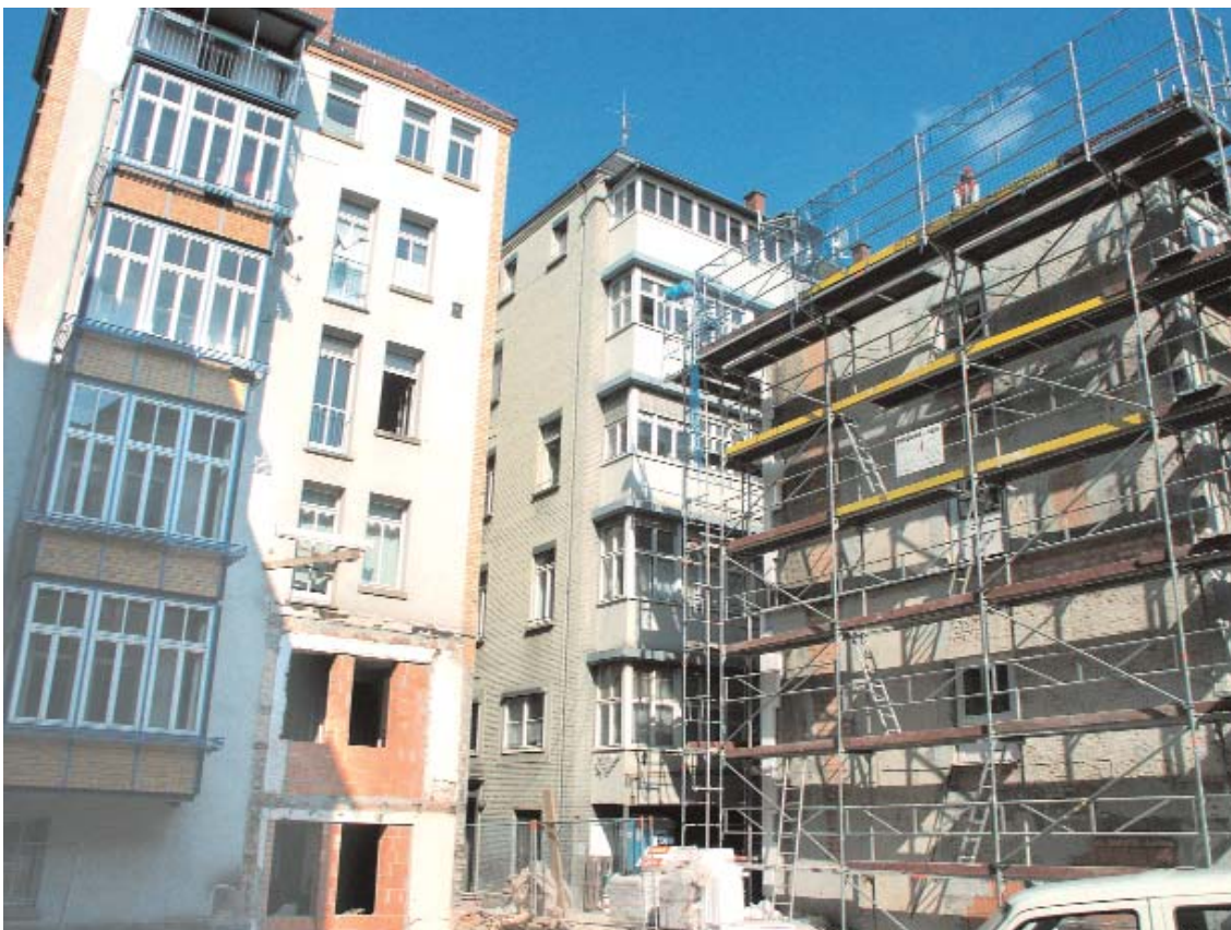
Stuttgart-Süd, Kolbstraße 4 B + C (Bestandssanierung sowie Teilabriss leerste- hender Gewerbeeinheit und Umnutzung zu Wohnungszwecken)
