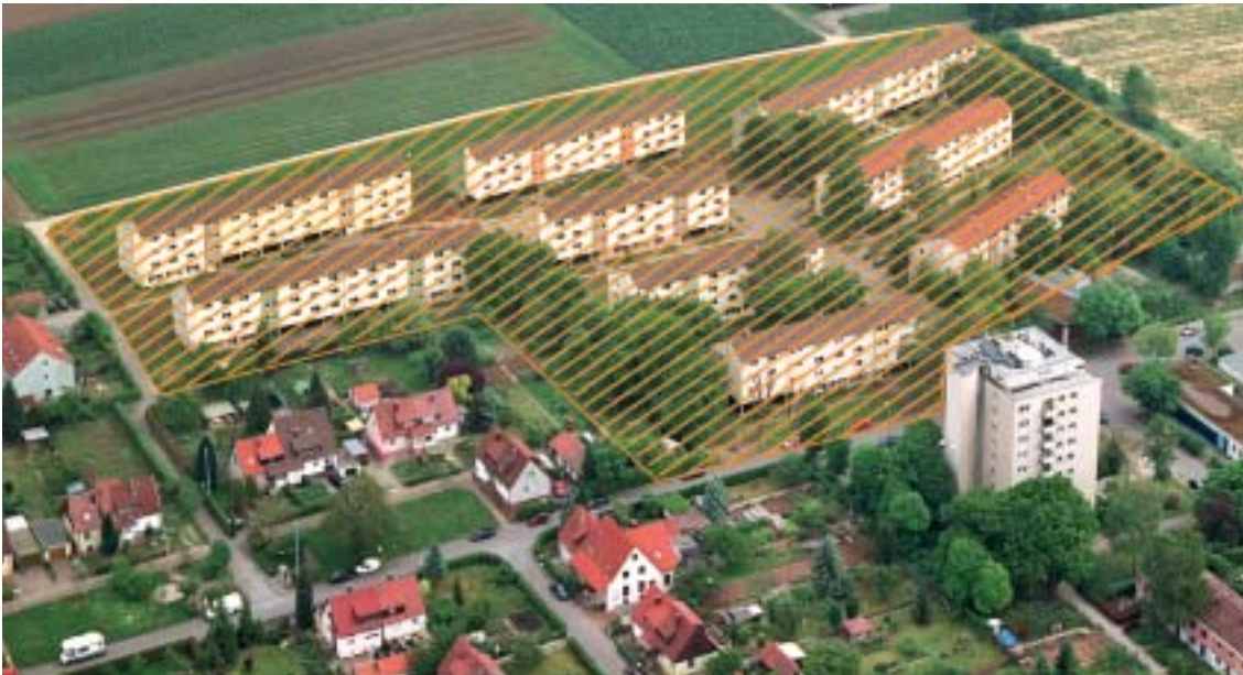
S-Steinhaldenfeld, Falchstraße (Siedlungsabriss und Neubebauung vorrangig im Wohneigentum)
