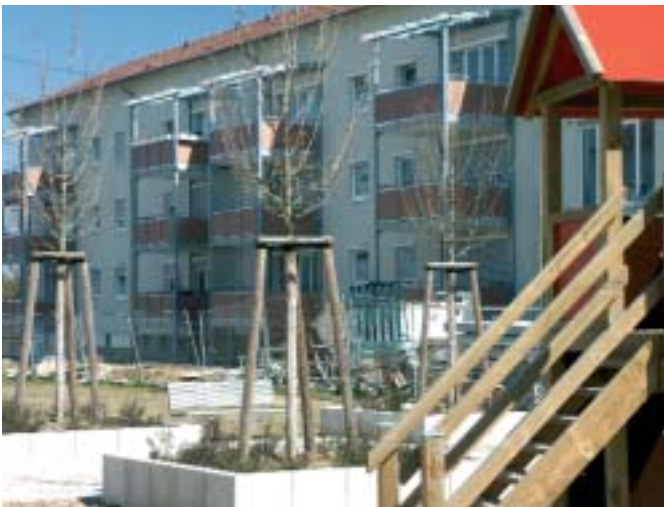
Stuttgart-Fasanenhof, Solferinoweg (Totalsanierung)
