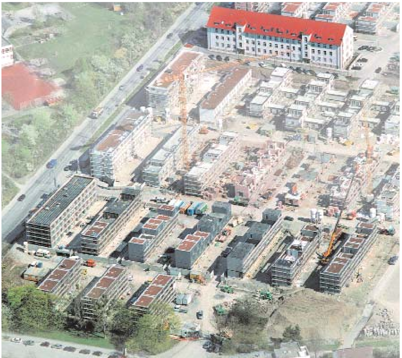
Bauplatz Mai 2002 (oben) und ein Jahr später (unten)
