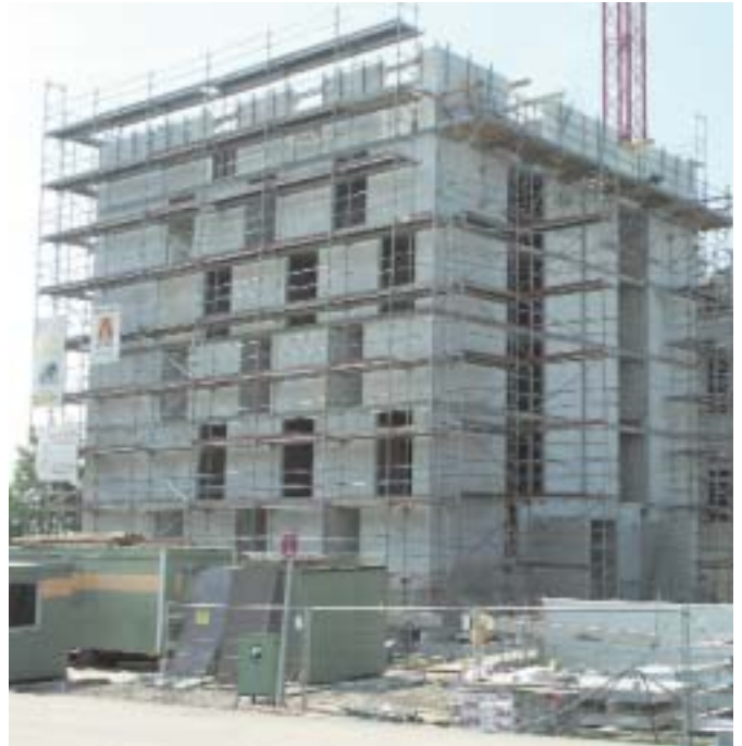
Aktueller Bautenstand Passivhäuser
