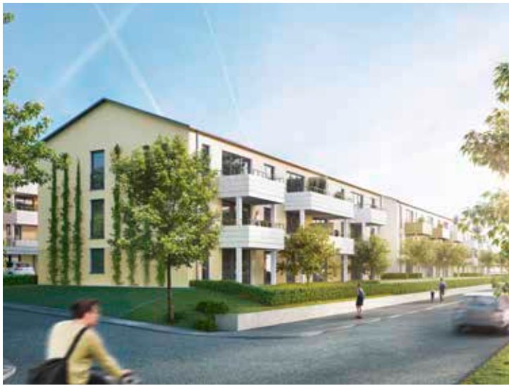
Ein Musterbeispiel für die Chancen der Innenverdichtung in Stuttgart bietet die Zazenhäuser Straße.
