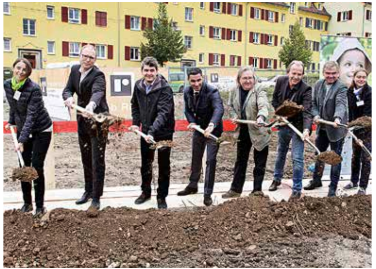
Schaufeln für den Baustart am Mehrgenerationenhaus, darunter SWSG-Geschäftsführer Samir Sidgi (Vierter von links) und rechts neben ihm Bürgermeister Peter Pätzold.
