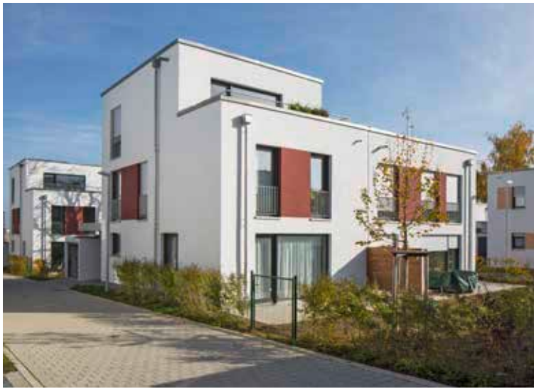
Die schmucken Häuser im ersten Bauabschnitt des Roter Stichs sind fertig.
