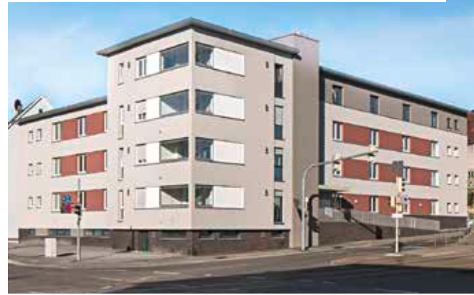
Für Senioren bietet die SWSG an der Ecke Talstraße/Rotenbergstraße eine neue Heimat.
