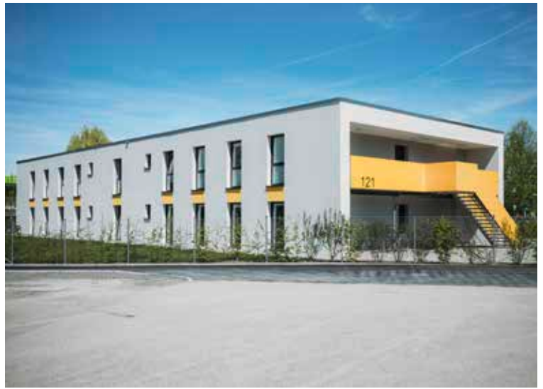
In der Solitudestraße in Stuttgart-Weilimdorf hat die SWSG Systembauten für Flüchtlinge errichtet.
